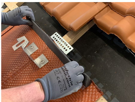
Kehldichtstreifen anbringen
