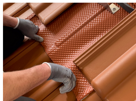
PV flex mit Haken an die Kontur des Ziegels anformen
