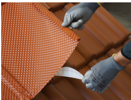
Schutzfolie des Butylklebestreifens abziehen
